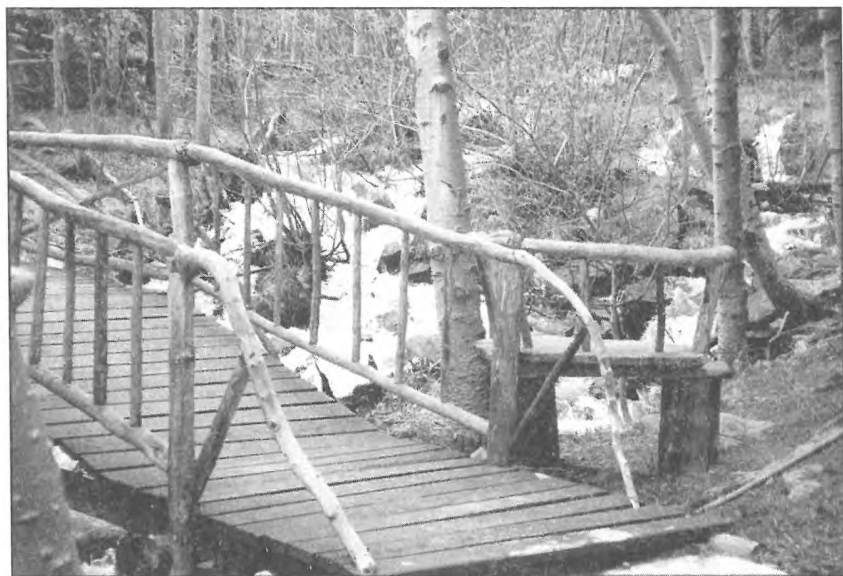
Aspen bridge over Como Creek (J. Kindig)
